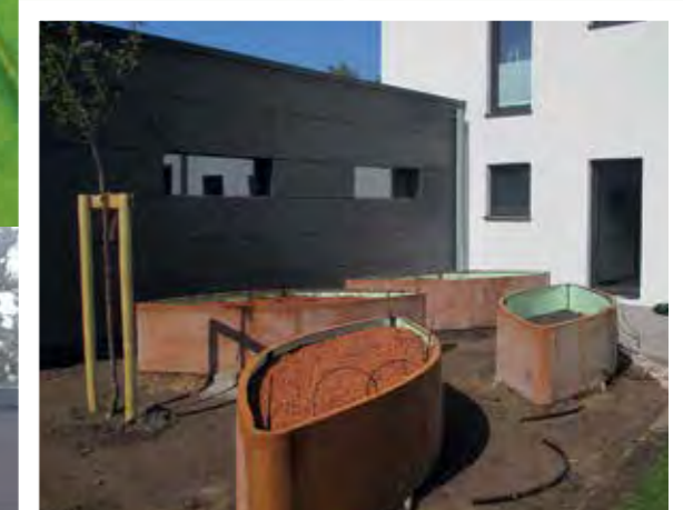
Einbau des Bewässerungssystems
