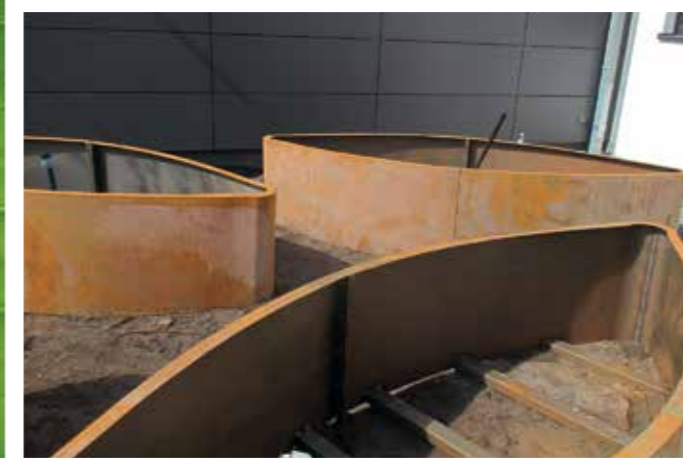
Auf der Baustelle, bereits mit Flugrostpatina
