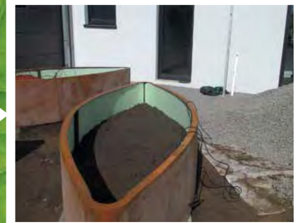
Dämmung aus Styrodur im Innenbereich
